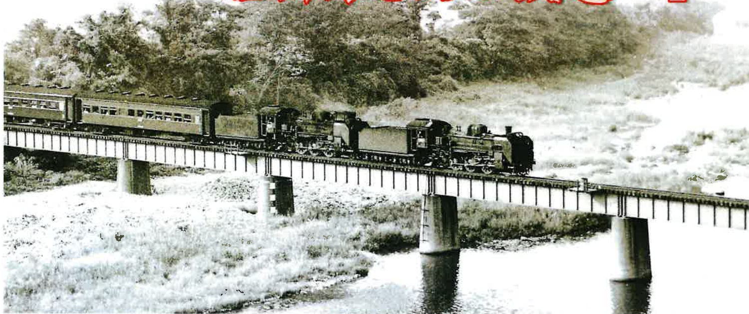
揖保川鉄橋の蒸気機関車(C58 重連) 神澤誠一氏撮影
